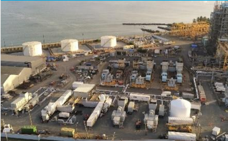
Palo Seco Fast Power 175 MW
